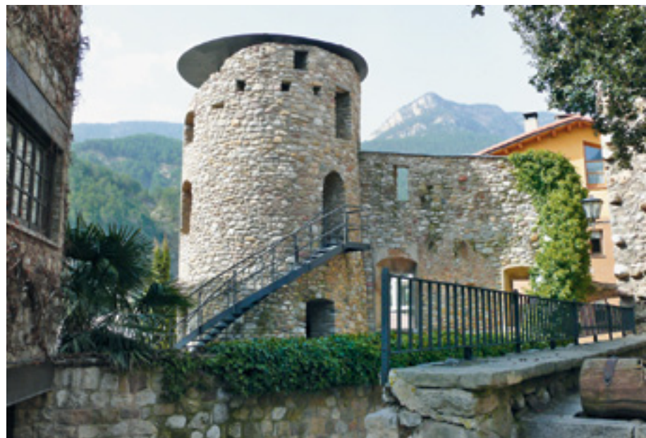
Torreón del sector noroeste del recinto amurallado de la villa de Bagà, desde la plaza de Galceran de Pinós
