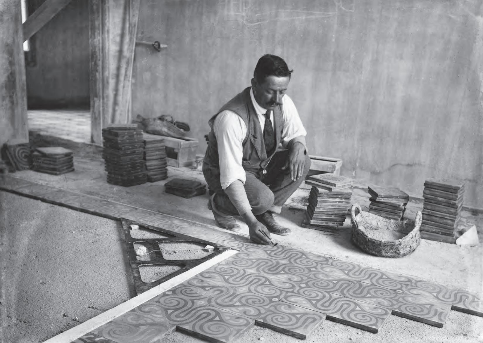
Trabajos de alineación y colocación de baldosas de mosaico hidráulico.
