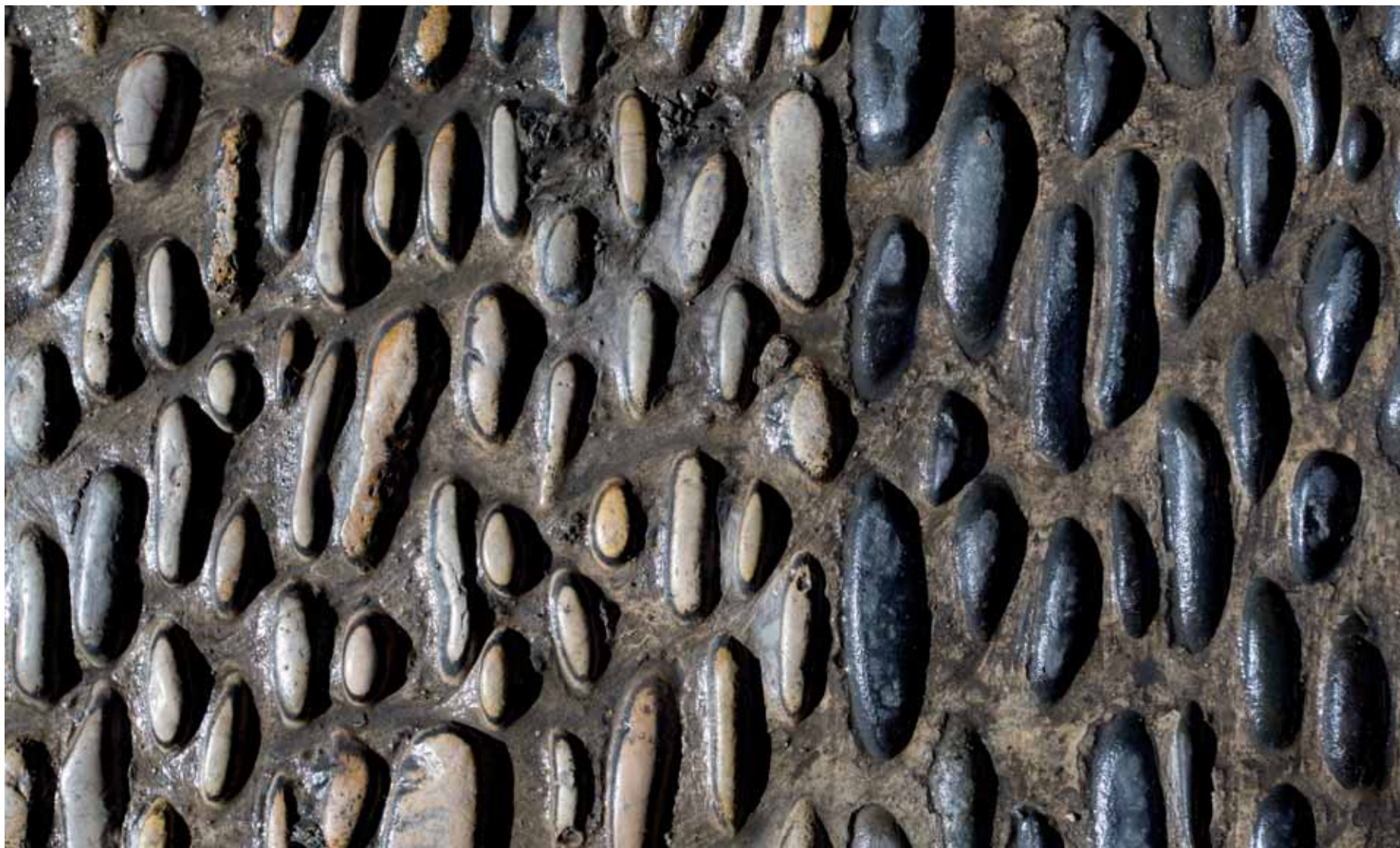
Detalle del pavimento de la calle Granada.
